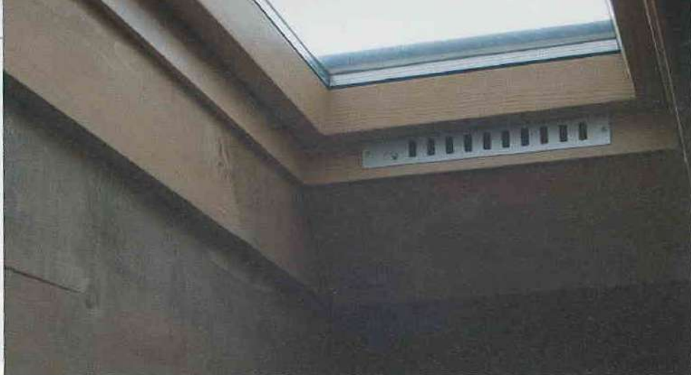
Una delle finestre per mansarde.
