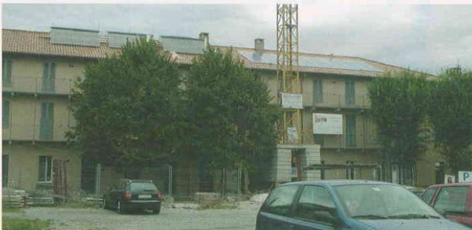
L'ala della Corte Nuova di Concorezzo in fase di rinnovo. In apertura, un particolare delle porte d'ingresso alle scale interne.
