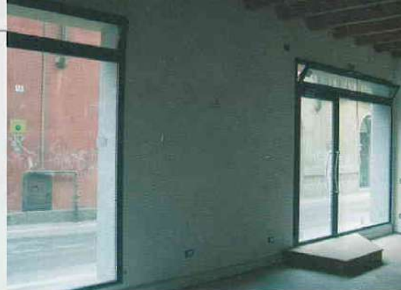
Serramenti in acciaio Jansen per i negozi sottostanti, con sopraluce motorizzato.
